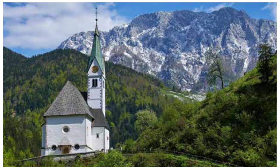
Gotska cerkev Marije Snežne v Solčavi - Uretex je izvedel sanacijo temeljnih tal z metodo Deep Injections (vir: www.visitsavinjska.si )
